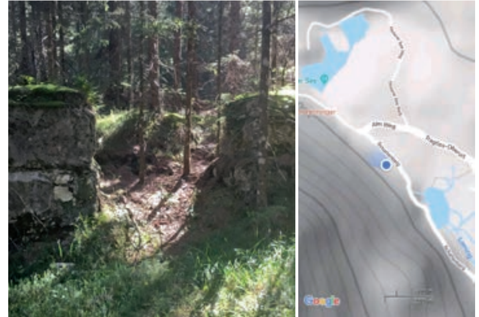
Überreste eines Betonfundaments eines Seilbahnmasts zwischen Grünem See und Kreuzteich, oberhalb der Schattenbergstrasse im Wald (blauer Punkt)
