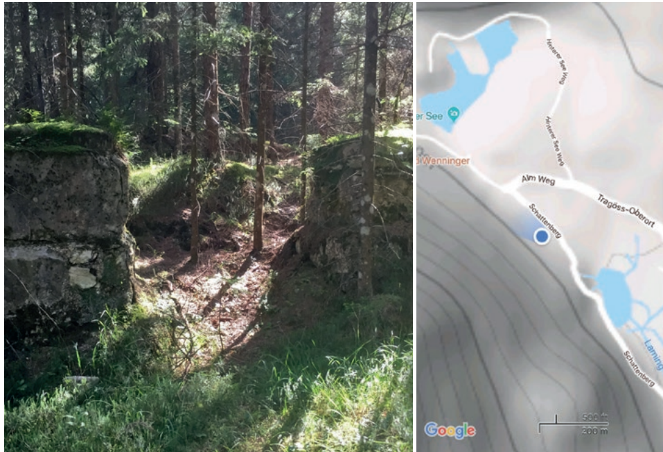
Überreste des Betonfundaments eines Seilbahnmasts zwischen Kreuzteich und Grünem See, oberhalb des Transformators im Wald (blauer Punkt)
